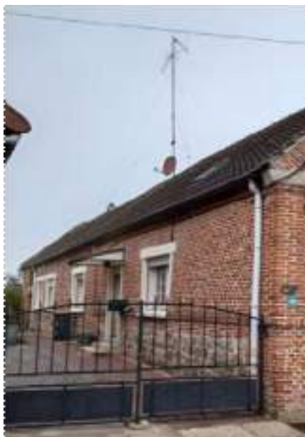
Devant les futurs logements
