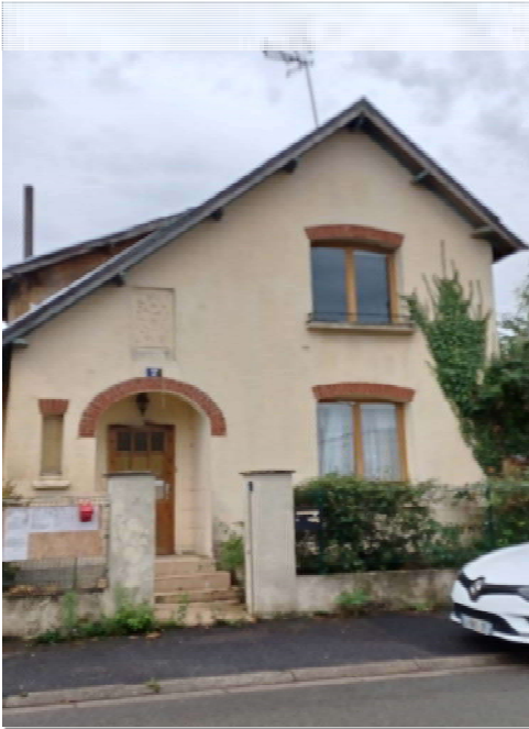
Devant le futur logement
