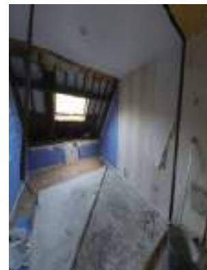
Sous les combles
