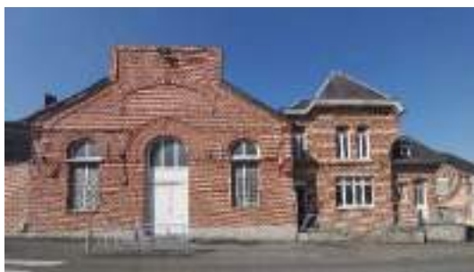
Devant les futurs logements (le 13 se situe au niveau de la porte d'entrée ouverte et l'entrée de l'ancienne poste est sur la droite)
